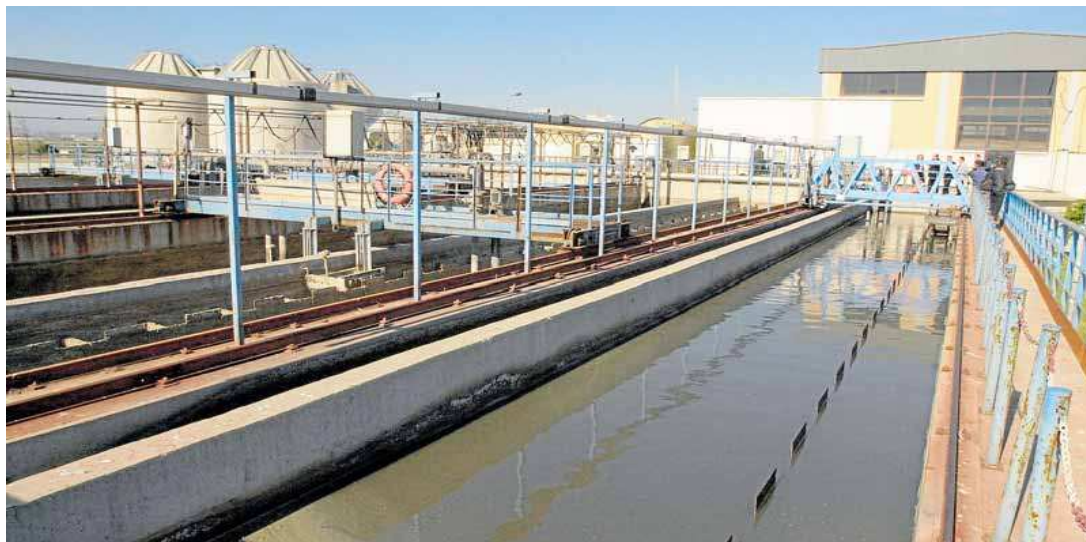
Imagen de la depuradora del Guadalhorce. SUR
