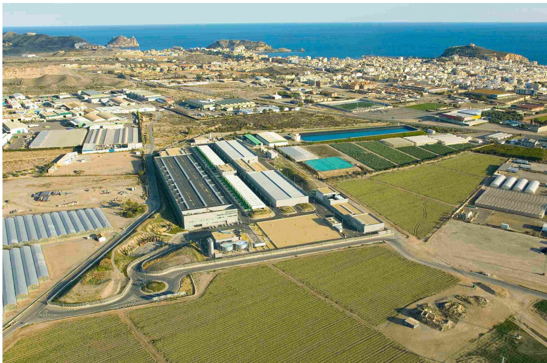
La desaladora de Águilas se prepara para dar servicio a nuevas concesiones de agua
